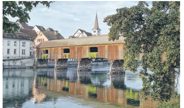
Die Rheinbrücke Diessenhofen muss saniert werden, das führt ab heute zu teilweiser Sperrung.
